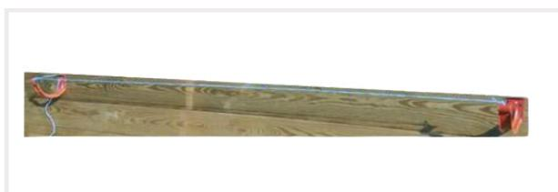
Placer ensuite les crochets intermédiaires en les espaçant de 70cm maximum. (60cm recommandé).
