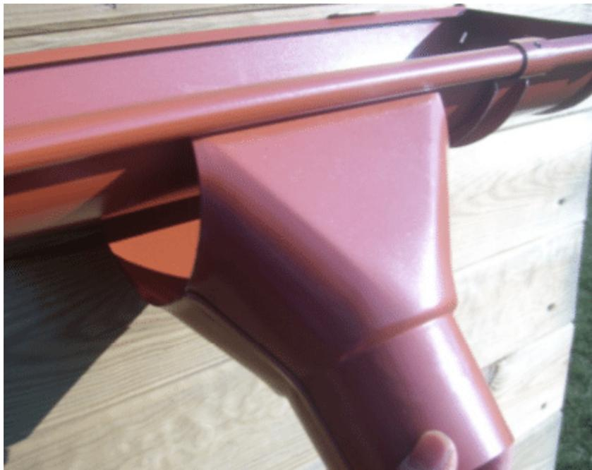
La basculer sur l'arrière pour laisser dépasser les languettes :
