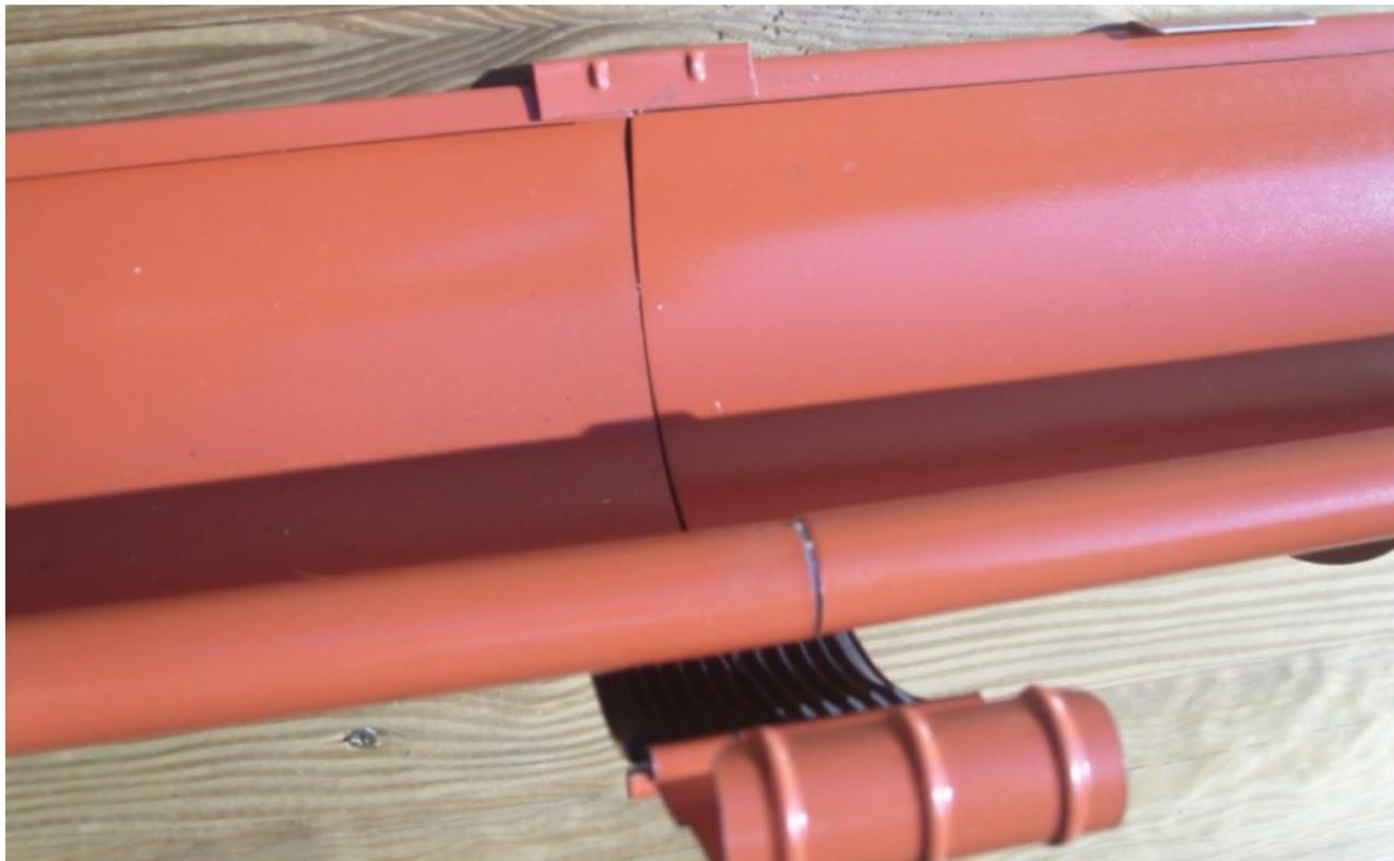
Puis insérer la pince sur la gouttière se trouvant sur les supports et mettre en place cette gouttière. Mettre en contact les deux gouttières et clipper la pince sur la partie arrière
