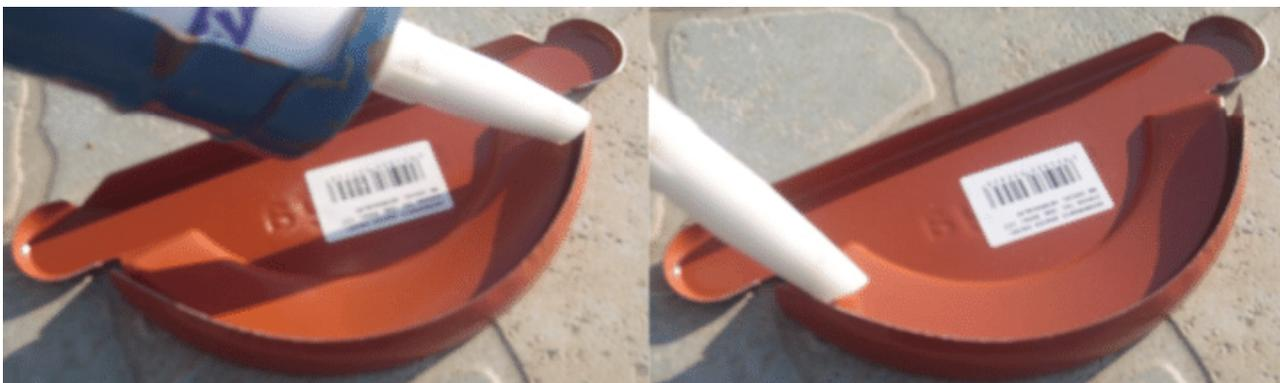
Placer ensuite le fond de gouttière sur la gouttière et clipser l'arrondi du fond de gouttière sur l'arrondi de la gouttière.
